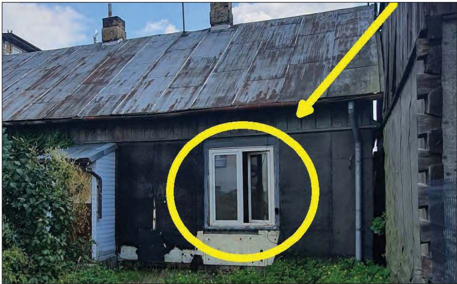
➤ Gdy udaliśmy się na miejsce, zastaliśmy okna uchylone, tak, jak informował Michał Kisiel
