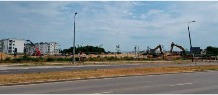
Na placu budowy galerii trwają prace ziemne
