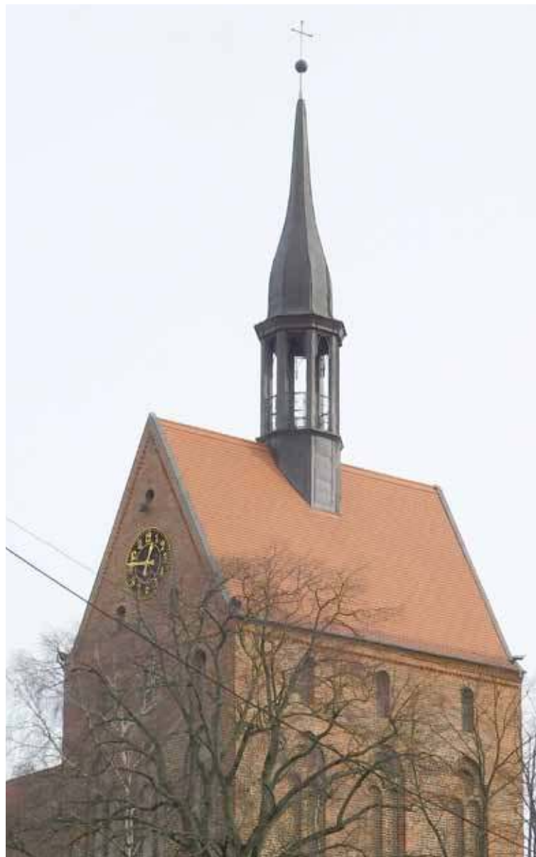
Narazie brak informacji w jaki sposób, w którym miejscu na tej wieży zostaną zamontowane elementy nadajników telekomunikacyjnych
