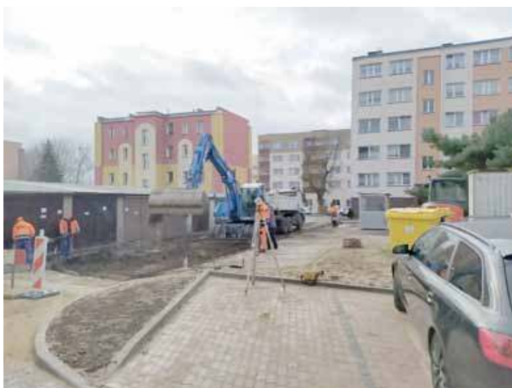
Obecnie prace koncentrują się na odcinku wzdłuż garaży
