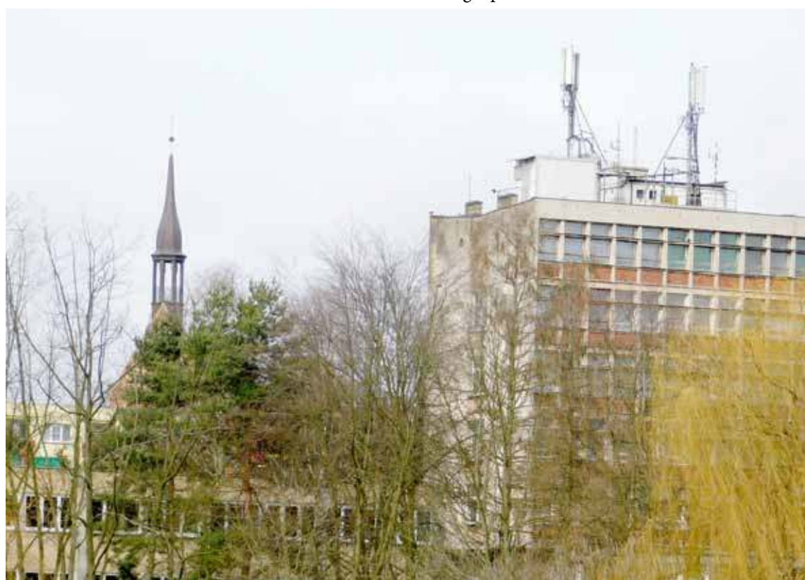
Dotychczas w centrum „sieją” anteny z „biurowca”. Wkrótce dojdą te zamontowane na widocznej wieży
