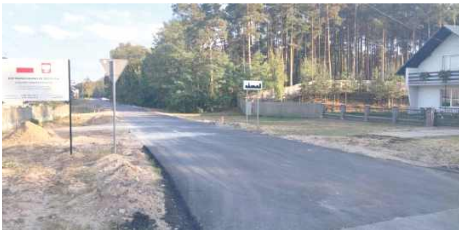
Przy końcu października koniec remontu drogi w Nowym Lipowcu
