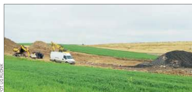
Prace przy budowie PSZOK-u trwają
