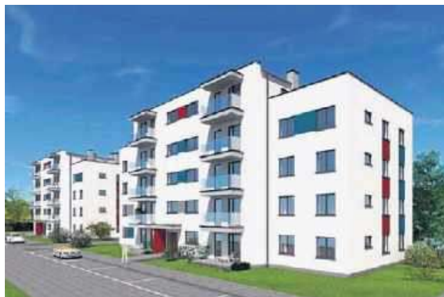
Za inwestycję odpowiedzialna jest lokalna spółka W. P. Investbud. W ramach budowy „Osiedla Powiśle” powstaną dwa bloki.
