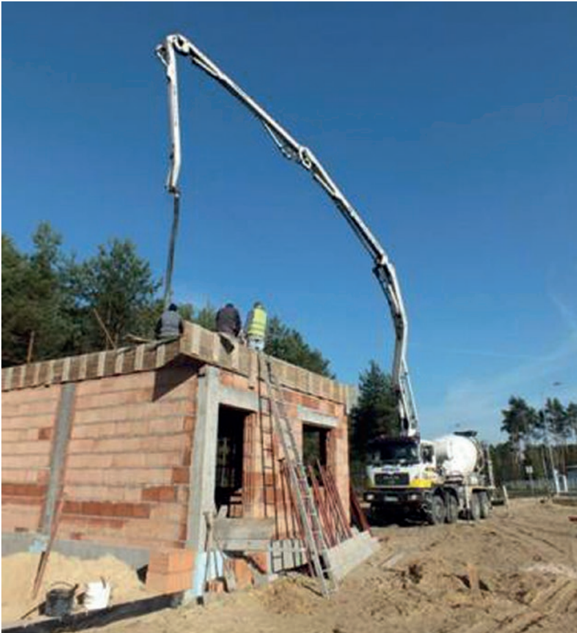
Budowa Rupociarni 2 przy ulicy COP
