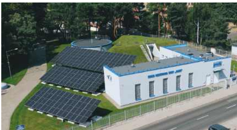
Instalacje fotowoltaiczne na SUW Piaski
