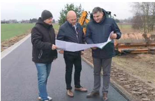
Kontrola remontu drogi w Kaniwoli
