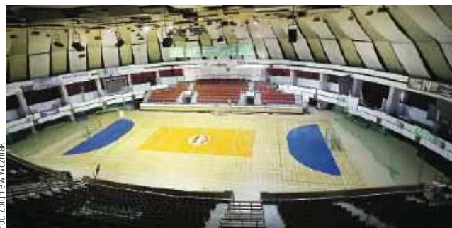
Hala Urania została wybudowana w 1978 roku
