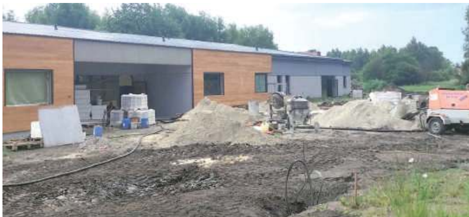
Prace na budowie żłobka z przedszkolem są już zaawansowane
