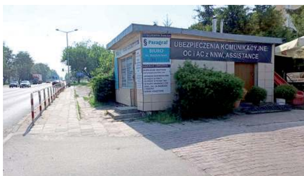
Zdaniem Zarządu Dróg Wojewódzkich ścieżka nie została dokończona, bo konieczny jest wykup działki z tym niewielkim budynkiem i wyburzenie go
