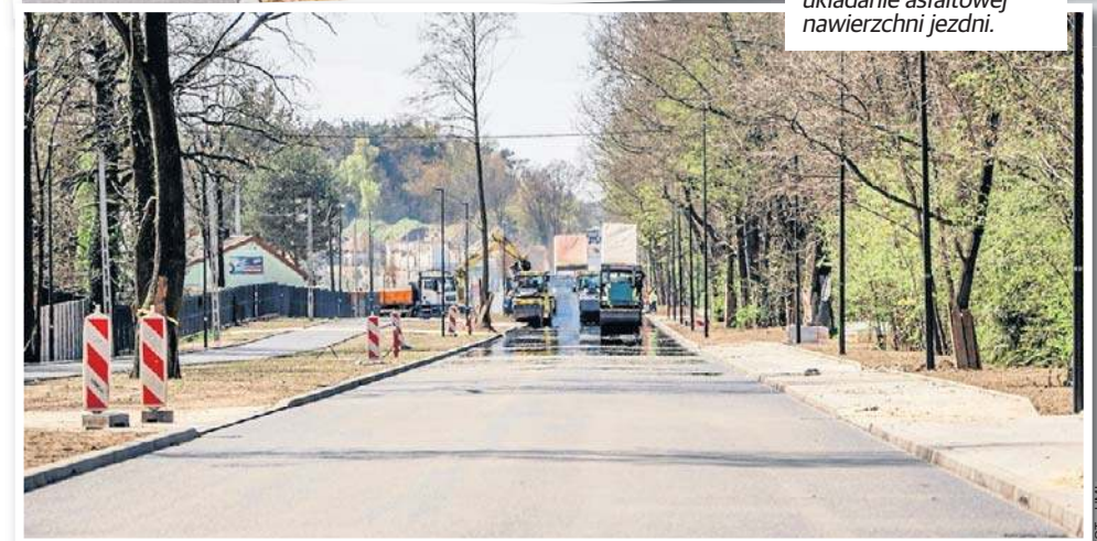
Drogowcy rozpoczęli układanie asfaltowej nawierzchni jezdni.
