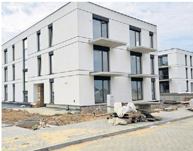
Nowe budynki w Czernikowie przy ulicy Akacjowej są już niemal gotowe
