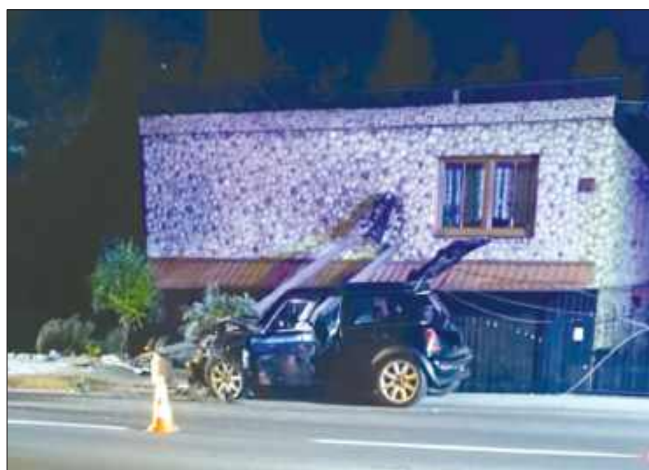
■ Samochód ściął słup, który przewrócił się na budynek.
