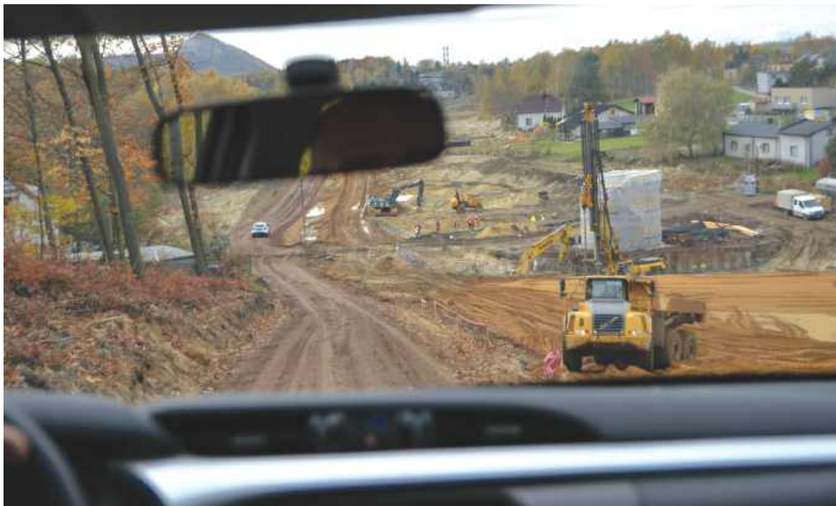
■ Tak wyglądał plac budowy rybnickiego odcinka drogi Racibórz – Pszczyna. Dziś inwestycja w Rybniku jest na ukończeniu, trwają procedury odbiorowe. O takiej sytuacji mogą pomarzyć mieszkańcy powiatu wodzisławskiego FOTO: ARCH. UM RYBNIK
