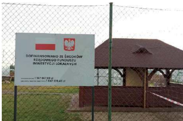
Budowa, która rozpoczęła się w połowie maja zakończyć się ma w grudniu br.
