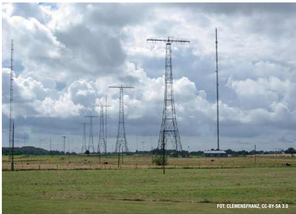
Wieże i anteny stacji radiowej Grimeton. Każda wieża antenowa ma 127 m wysokości, a ramię poprzeczne ma 46 m szerokości
