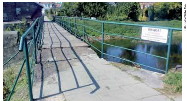
Przejście zostanie zamknięte do czasu trwania zadania inwestycyjnego, zaś planowany termin zakończenia prac to 30 listopada 2021 roku.
