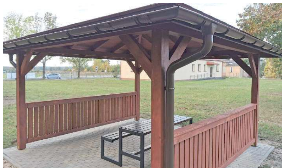
Urządzenia zamontowała firma Fit Park z Torunia
