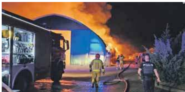
Wiata, która spłonęła, miała wymiary 60 metrów na 15 i około 6 metrów wysokości
