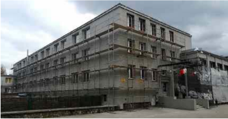
Termomodernizacja „Budowlanki” idzie pełną parą
