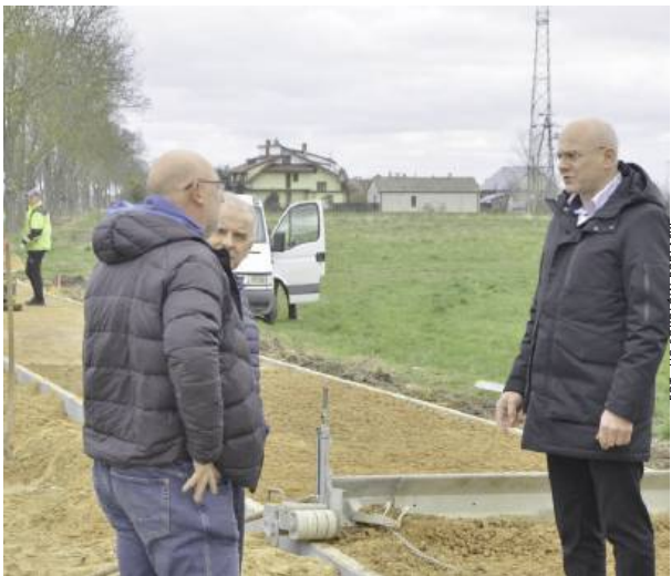
Przebieg prac nad przebudową drogi
