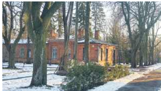
Umowa podpisana z wykonawcą dotyczy przebudowy pierwszego z budynków dawnych koszar za dawnym domem weselnym „Nasza Chata”
