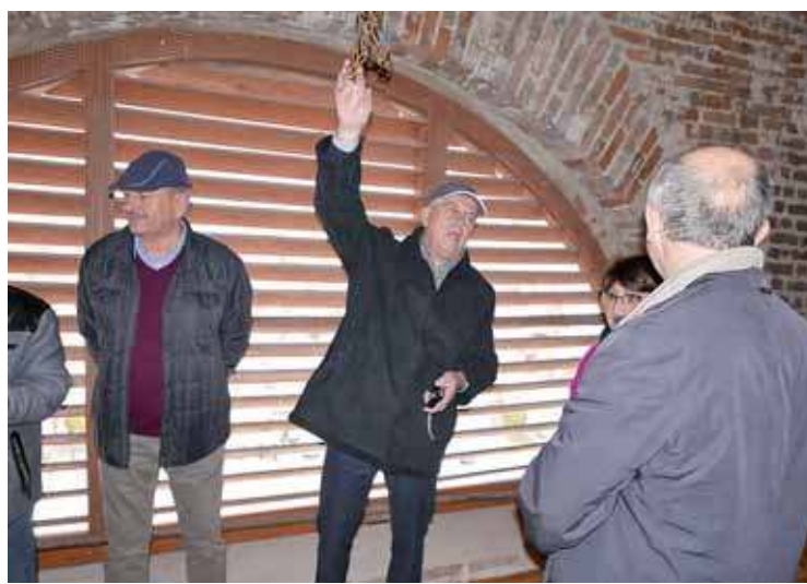
Jan Radecki (pierwszy od lewej) podczas odbioru prac we wnętrzu dzwonnicy
