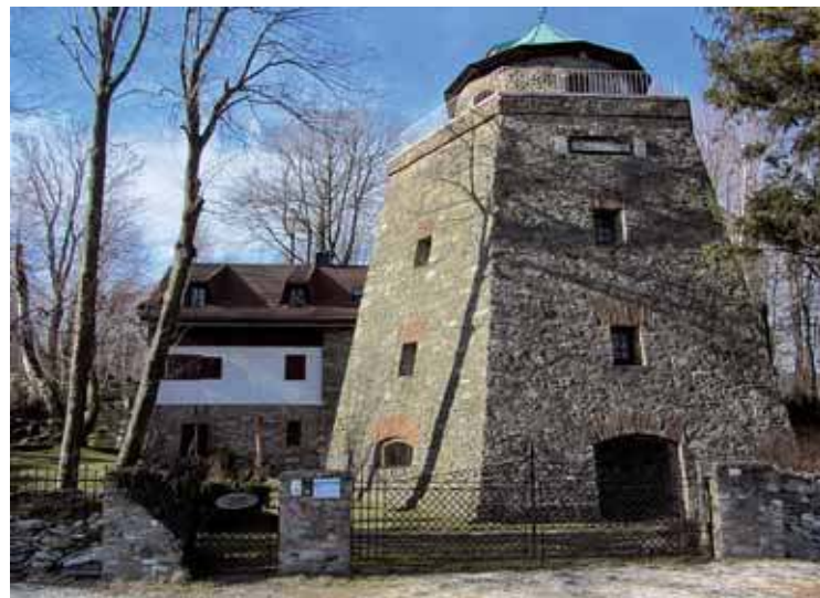
Piec wapienny z surowego kamienia
