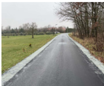
Wyremontowana ulica Nasypowa.
