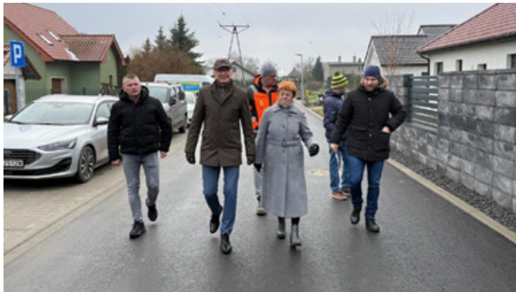
Ul. Zbożowa - odbiór prac budowlanych.
