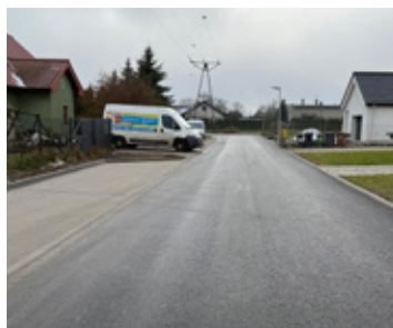
Wyremontowana ulica Zbożowa.
