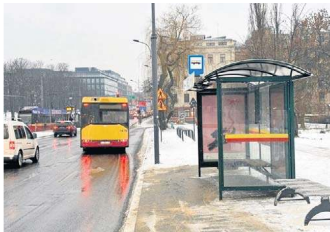
Przystanki na Zachodniej przy Manufakturze zostaną przebudowane
