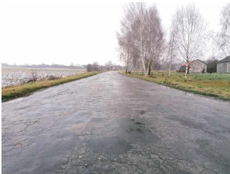
Do wykonania pozostał 3,2-kilometrowy odcinek drogi powiatowej relacji Głusko – Wolica – Kowala
