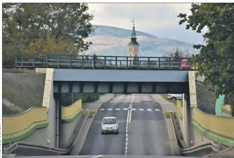
W ramach inwestycji odnowiony zostanie liczący 1 km odcinek ul. Powstańców Śląskich w Prudniku
