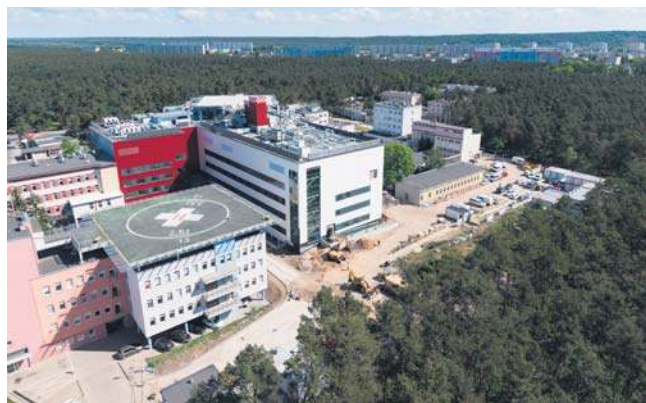
Trwająca rozbudowa Wojewódzkiego Szpitala Specjalistycznego we Włocławku FOT. MIKOŁAJ KURAS DLA UMWK
