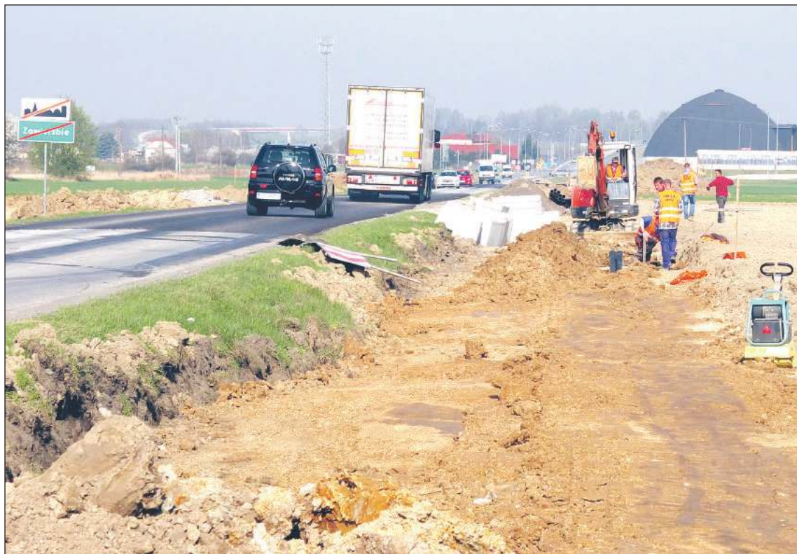
W ramach tej samej inwestycji przebudowywana jest droga łącząca autostradę z Zawierzbiami, do granic tej wsi.
