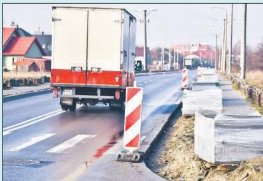
Na Kosynierów Raclawickich trwa przebudowa.
