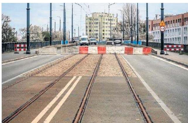
W piątek miasto ogłosiło przetarg na prace remontowe całej konstrukcji, które potrwać około dwóch lat
