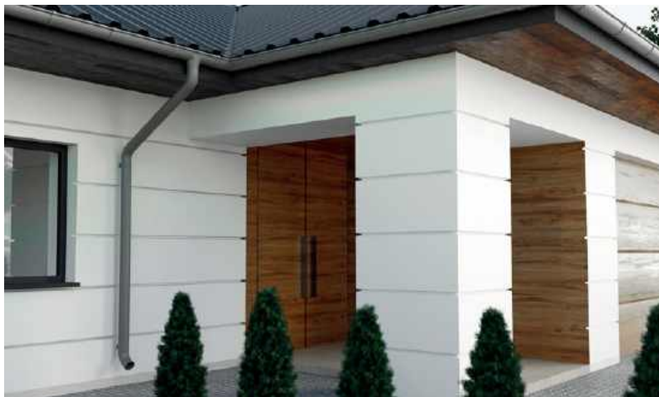
❷ Jako że boniowanie jest elementem ozdobnym, powinno zostać wykonane z uwzględnieniem innych linii i podziałów w bryle domu, w tym łączeń paneli w bramie garażowej. BELLA PLAST
