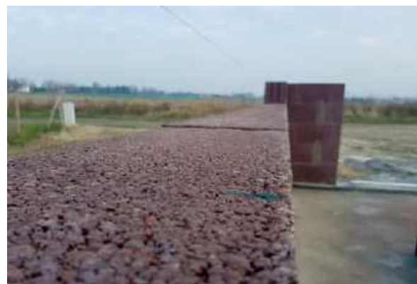
🔹 Keramzytobeton jest porowaty, lekki i ma dobrą izolacyjność akustyczną. Ponadto ma dobre parametry cieplne. CZAMANINEK
