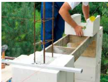
Ułożenie kształtek U na podporach montażowych
