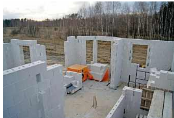
🔹 Wyróżnikiem bloczków silikatowych jest duża wytrzymałość na ściskanie. Dzięki temu warstwa konstrukcyjna ściany może mieć zaledwie 18 cm grubości. H+H
