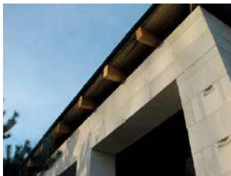
Podpory montażowe można usunąć po 28 dniach od zalania betonem
