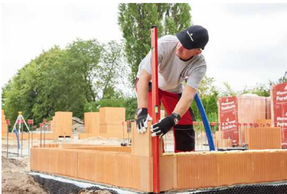
🔹 Cechą charakterystyczną ceramiki poryzowanej jest – jak wskazuje nazwa – porowata struktura. Dzięki temu jest ona cieplejsza i lżejsza od tradycyjnej, co wpływa na szybkość budowy. WIENERBERGER
