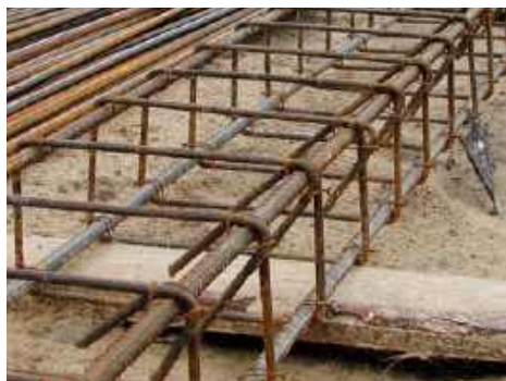
Przygotowanie zbrojenia
