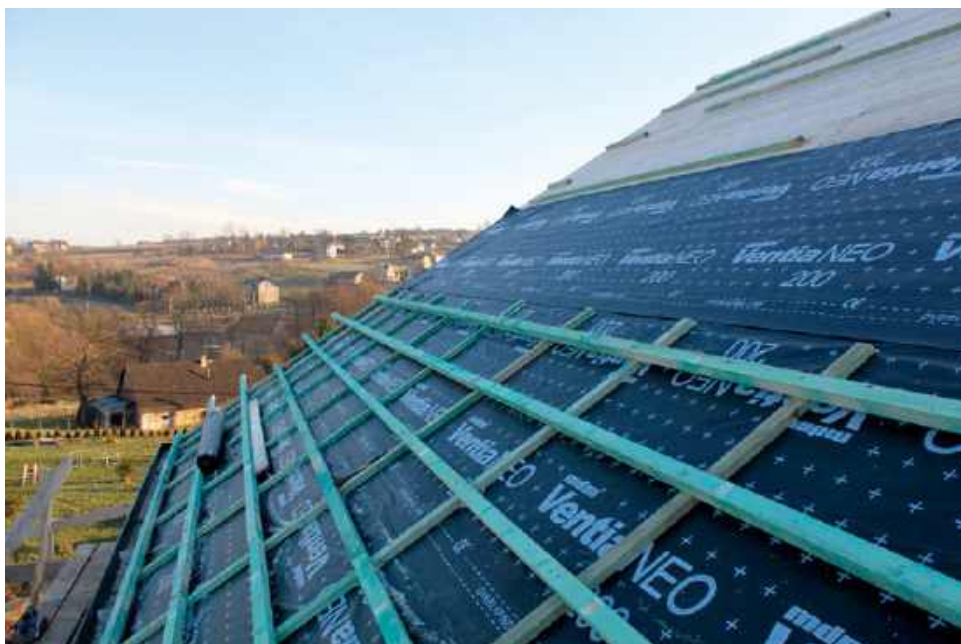
📍 Membrany dachowe to dziś nieodzowny element dachu skośnego. MDM NT
