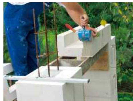
Naćłożenie zaprawy murarskiej (przed nałożeniem zaprawy murowanej powierzchnie należy oczyścić z pyłu)
