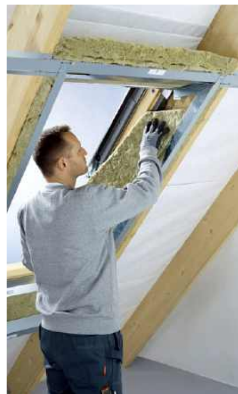
Układanie izolacji termicznej dookoła okna. VELUX
