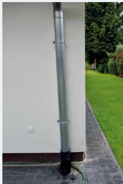
Dwuspadowy dach orynnowano systemem z blachy cynkowo-tytanowej.
