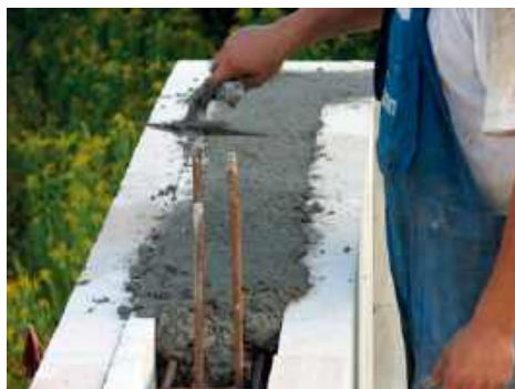
Zalanie mieszanką betonową (niezbędne jest zagęszczenie mieszanki za pomocą wibratora)
