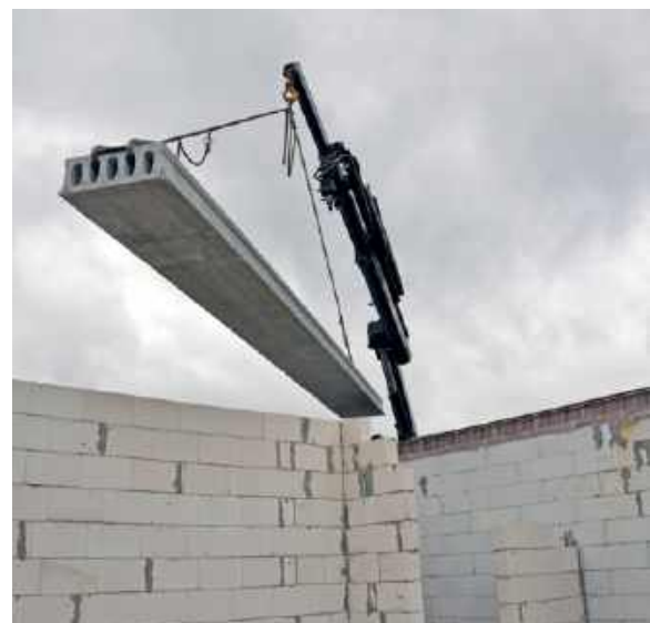
ⓘ Dużą zaletą stropów panelowych jest błyskawiczny montaż – 100 m 2 stropu można ułożyć zaledwie w 2 godziny. STROPY.PL
