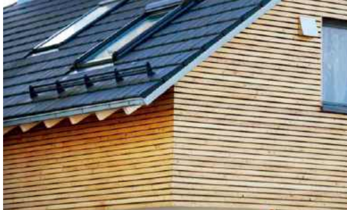
📌 Elewacja wykończona drewnem z daglezji, jednego z najbardziej stabilnych wymiarowo egzotycznych gatunków iglastych. JAF POLSKA
