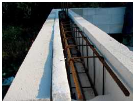
Ułożenie zbrojenia do szalunku w kształtkach U (jeśli to konieczne, to należy w kształtkach U umieścić również ocieplenie)
