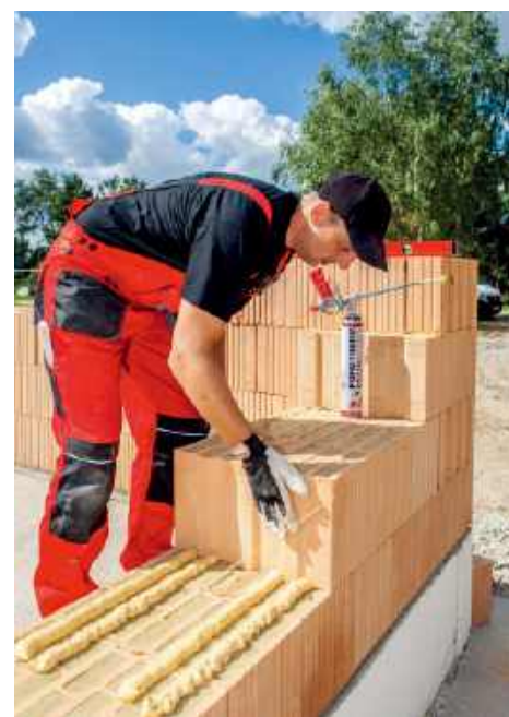
🔧 Budowanie po nowemu – pustaki klejone pianą z puszki. WIENERBERGER
