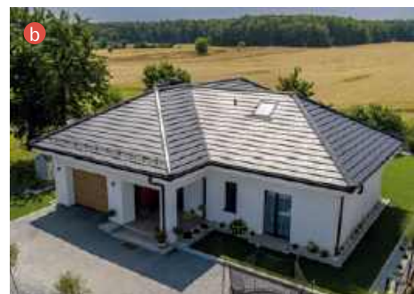
🔦 Bardzo różne materiały pokrywowe mogą na dachu wyglądać podobnie. Na zdjęciach blachodachówka, czyli pokrycie lekkie (a RUUKKI) i pokrycie ciężkie z dachówki (b CREATON POLSKA).
