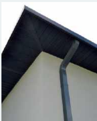
🔗 Stalowe, kwadratowe rynny (90 x 90 mm) efektywnie odprowadzają wodę z dachu.
