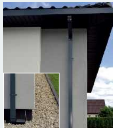
🔗 Systemowa maskownica na okapie zastępuje rynnę, dolny wpust przekazuje wodę pod trawnik i do studni chłonnej.
