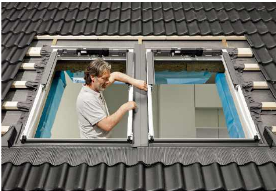
❶ Okna połaciowe można montować pojedynczo, albo w zestawach. VELUX
