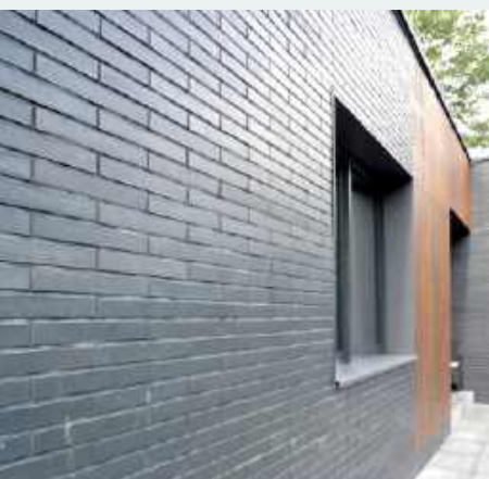
Przy okładzinie z klinkieru ułożono oblicówkę z drewna egzotycznego.
