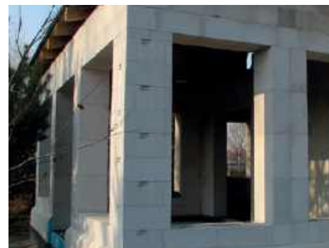
Widok końcowy. Nad otworami wykonano żelbetowe belki w szalunku traconym z kształtek U (również kształtki zastosowano by wykonać w nich słupy żelbetowe)
