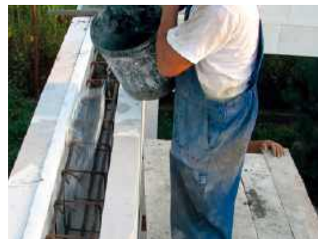
Dobrze jest zwilżyć wodą szalunek z kształtek U
