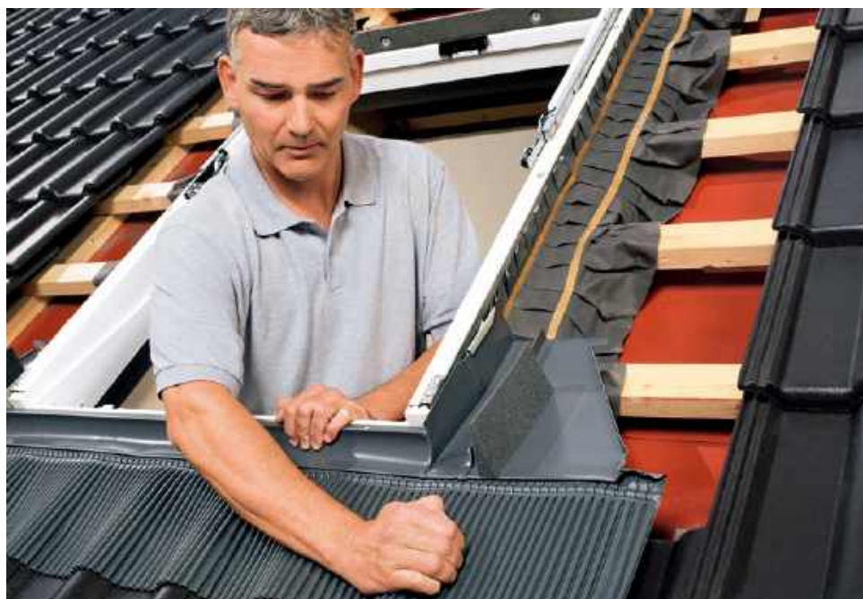
Montaż dolnego fragmentu kołnierza z fartuchem. VELUX
