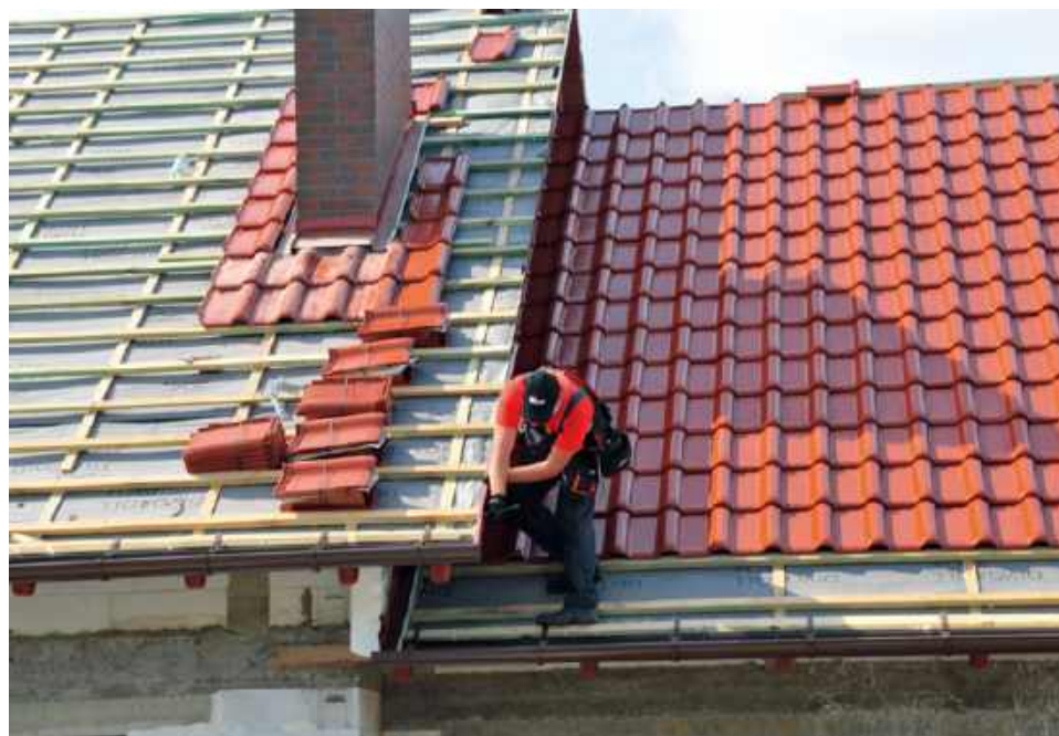
🔧 Pokrycie z dachówki układane na ruszcie z łąt i kontrłąt. RÖBEN
