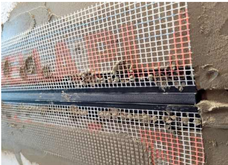
❶ Listwę systemową wciska się w wyfrezowany rowek wypełniony klejem. Na tym etapie, listwa jest jeszcze zamkniętym profilem. Dzięki zintegrowanej siatce, po wklejeniu w elewację, profil będzie bardziej stabilny. BELLA PLAST
