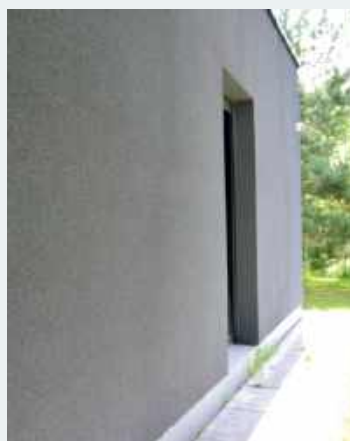
Do odcienia klinkieru, dopasowano kolor tynku silikatowego (zabarwionego w masie).
