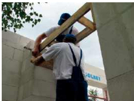
Wykonanie podpór montażowych dla szalunku w kształtkach U
