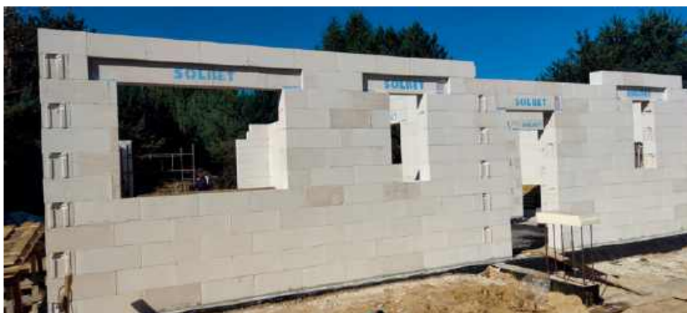
🔹 Beton komórkowy ma wiele zalet. To m.in. bardzo dobra termoizolacyjność, niska waga, duże rozmiary elementów, a także łatwość ich obróbki. SOLBET
