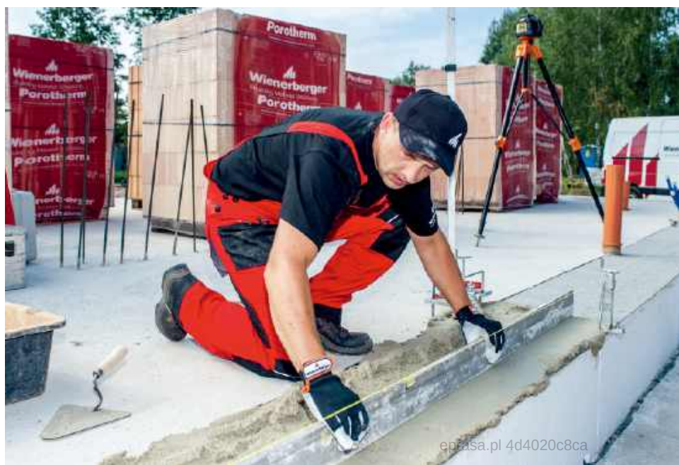
🔧 Pierwszą warstwę pustaków zawsze układa się na zaprawie tradycyjnej. WIENERBERGER
