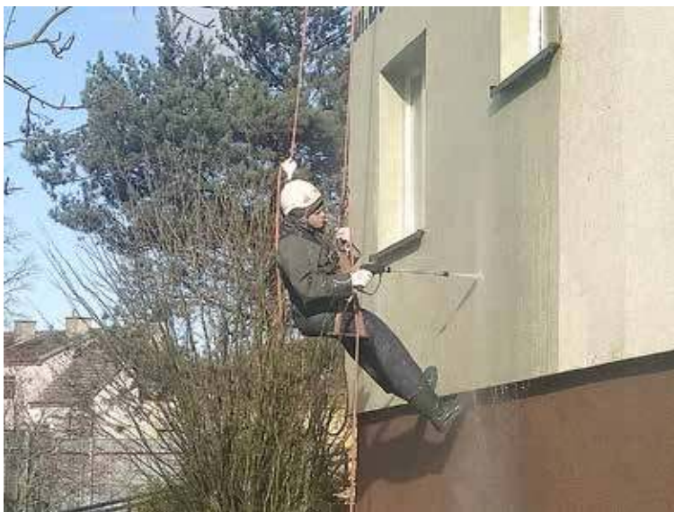
Prace odbywają się za pomocą sprzętu wspinaczkowego
