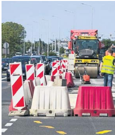
Trwa przebudowa torowiska tramwajowego
