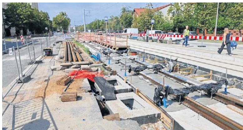
Na ulicy Kościuszki trwa przebudowa torowiska tramwajowego
