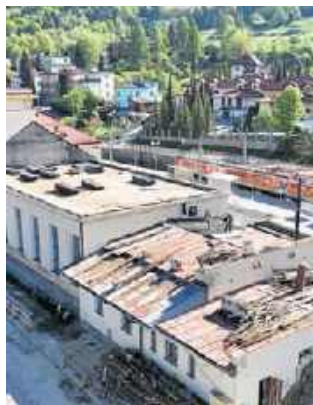
Totalny remont dworca kolejowego postępuje
