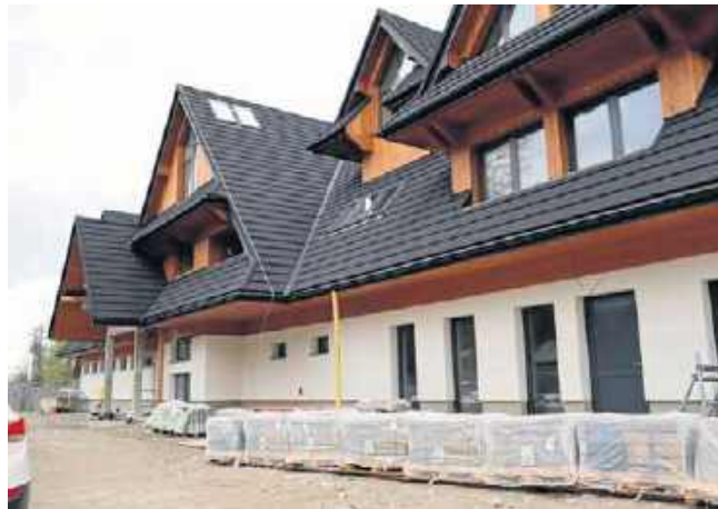
Budowa nowego ośrodka dla osób z niepełnosprawnością intelektualną utknęła
