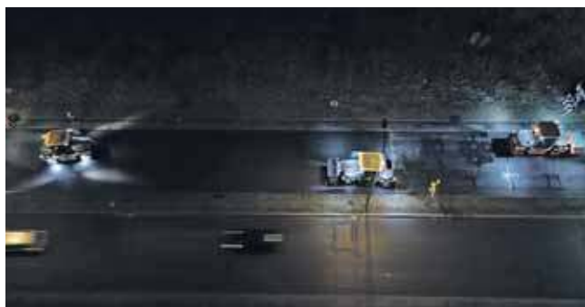
Aby zminimalizować utrudnienia, nawierzchnię układano w nocy
