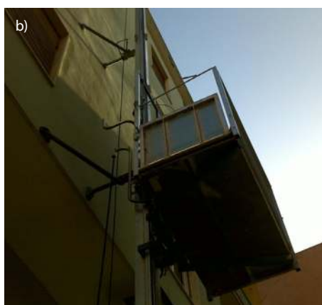
Fot. 2. Systemy kotwienia dźwigu towarowego GEDA 300Z:
