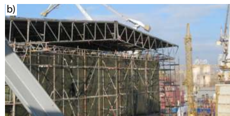
Fot. 2. Konstrukcja zadaszania oparta na rusztowaniach modułowych – projekt i wykonanie: Xervon Polska Sp. z o.o.
