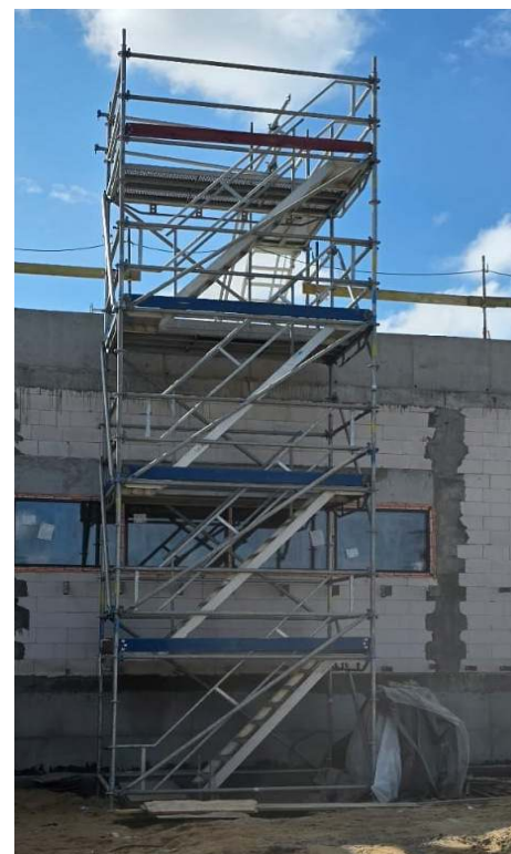
Fot. 2. Wolnostojąca konstrukcja schodni, wykonana przez firmę Jurgo
