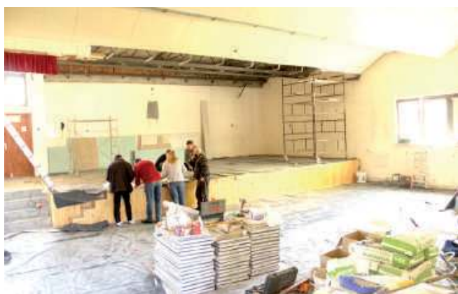
Tak aktualnie wygląda pomieszczenie sali widowiskowej Gminnego Ośrodka Kultury. Po remoncie widzowie zasiądą w nowych fotelach. Pojawi się również nowy ekran i kurtyna sceniczna
