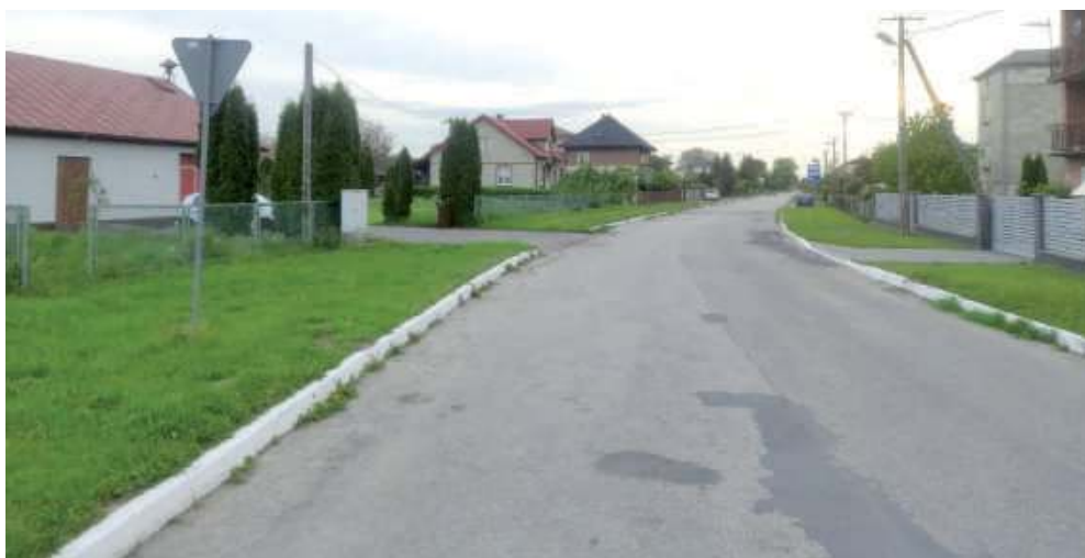
Tak aktualnie wygląda nawierzchnia drogi w Żerdzi - połatany, popękany i w niektórych miejscach pozapadany asfalt to codzienność kierowców przemierzających ten odcinek
