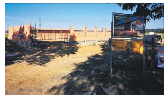
Trwają prace związane z budową Dino przy ulicy Ligonia w Gogolinie.
