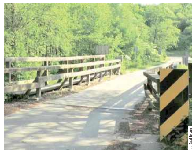
Remont mostu w Mareczkach potrwa do końca października
