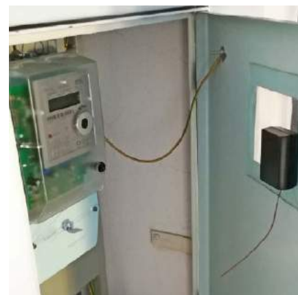
Fotografia 2. Przykład zamocowania modułu nadajnika
