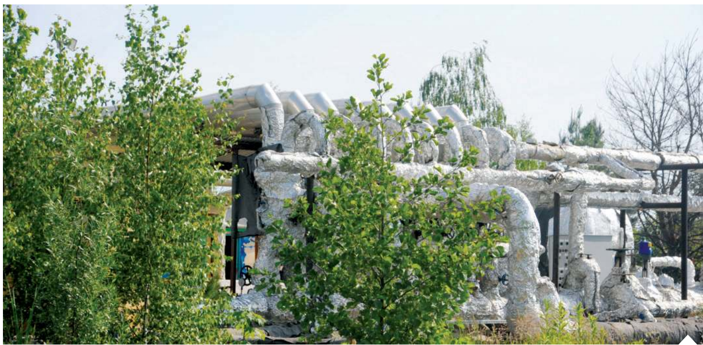
Unikalna metoda wydobycia siarki powoduje, że kopalnie Grupy Azoty Siarkopol wyglądają w sposób mało kojarzący się z tradycyjnym wydobyciem | fot. mat. pras.
