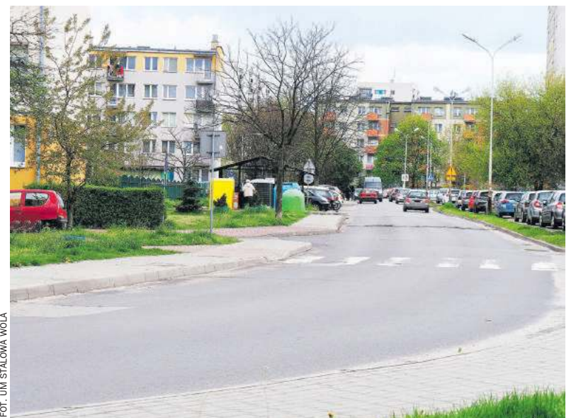
Przebudowie poddany zostanie odcinek drogi o długości 1434 metrów
