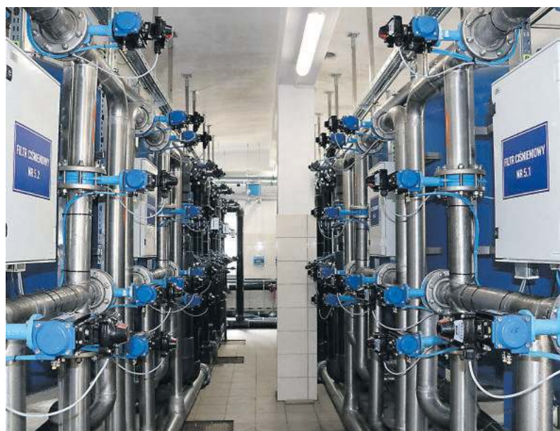
Rozbudowa stacji uzdatniania wody realizowana była etapowo
