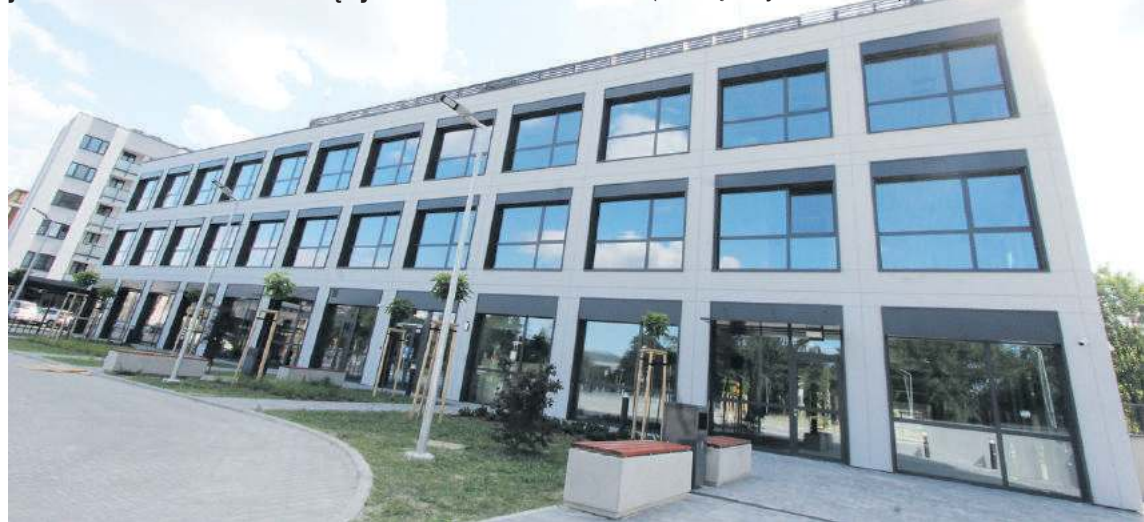
Wschodnia ściana budynku Urbi Ferro w zaletej okazałości
