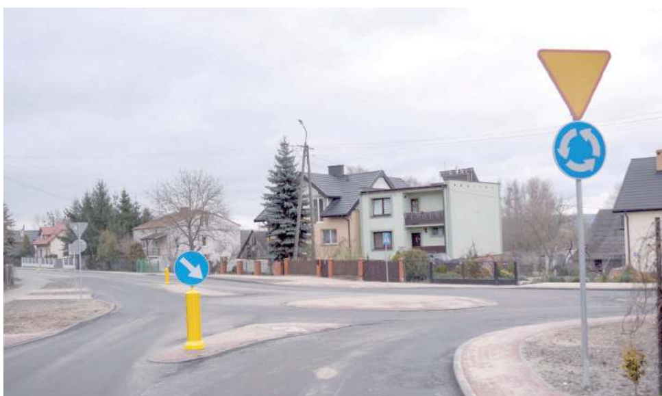
Na ul. Radomskiej i Spółdzielczej, przy rozwidleniu dróg na Ławeczko i Janowice, powstało pierwsze w gminie rondo, które ma poprawić bezpieczeństwo przejazdu. Wraz z nim wykonano nową nawierzchnię drogi i chodnika. Koszt tej części zadania do 1,1 mln zł
