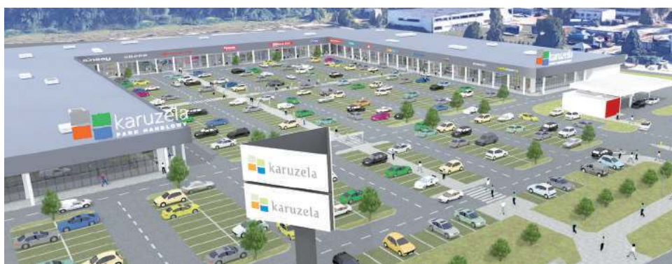
W miejsce supermarketu Tesco ma powstać nowe centrum handlowe „Karuzela”, którego powierzchnia będzie wynosić 15 000 tys. mkw. Obiekt ma zostać otwarty dla kupujących w drugiej połowie 2021 r
