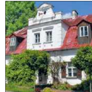
- To jeden z najstarszych zabytków w gminie Janów Podlaski. Budynek wymaga gruntownego remontu - wskazuje Karol Michałowski
