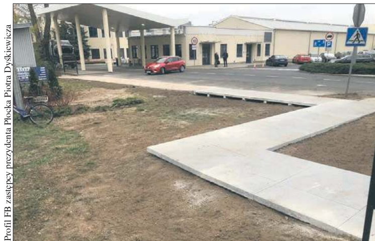
Podwieszany chodnik powstał pomiędzy ul. Ciechomicką a wejściem do zakładu produkcyjnego Dr. Oetker
