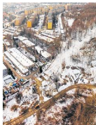
Budowa nowej drogi będzie kosztowała 7 mln zł
