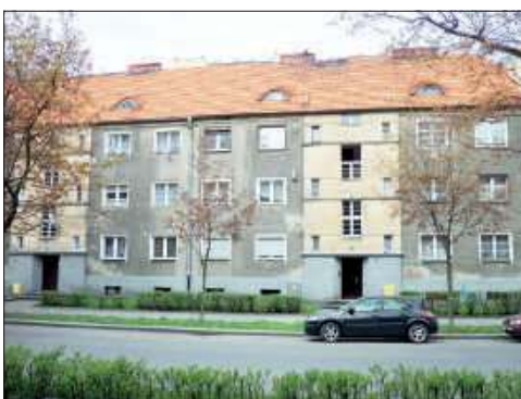
Budynki przy ul. Skłodowskiej przed modernizacją
