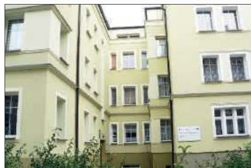
Kamienica przy ulicy Czekoladowej po modernizacji zakończony w 2020 roku
