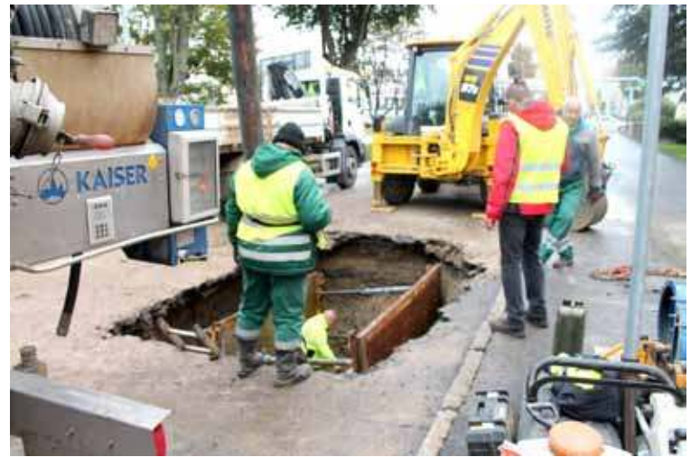
Prace naprawcze trwały od godziny 15 a zasypowe do wieczora
