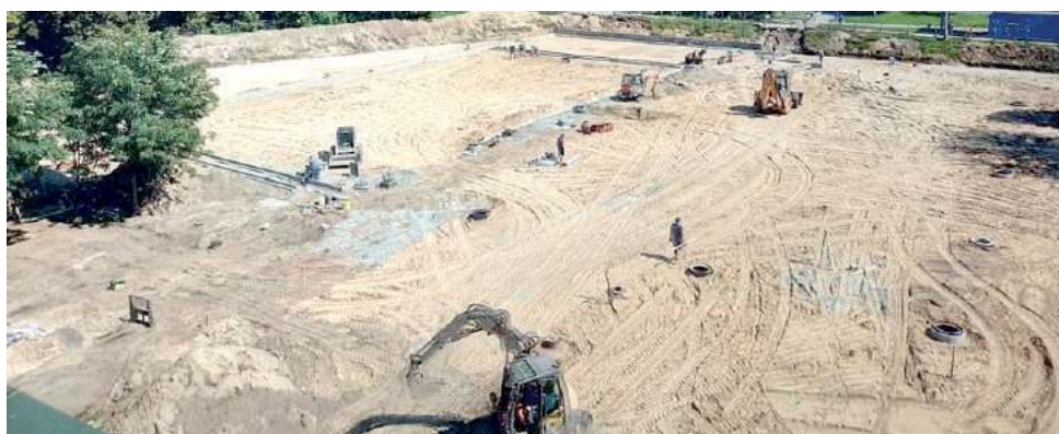
Teren wokół Szkoły Podstawowej nr 6 im. Polskich Lotników zamienił się w wielki plac budowy. Uczniowie doczekają się nowego boiska szkolnego, które zostanie ukończone za dwa miesiące
